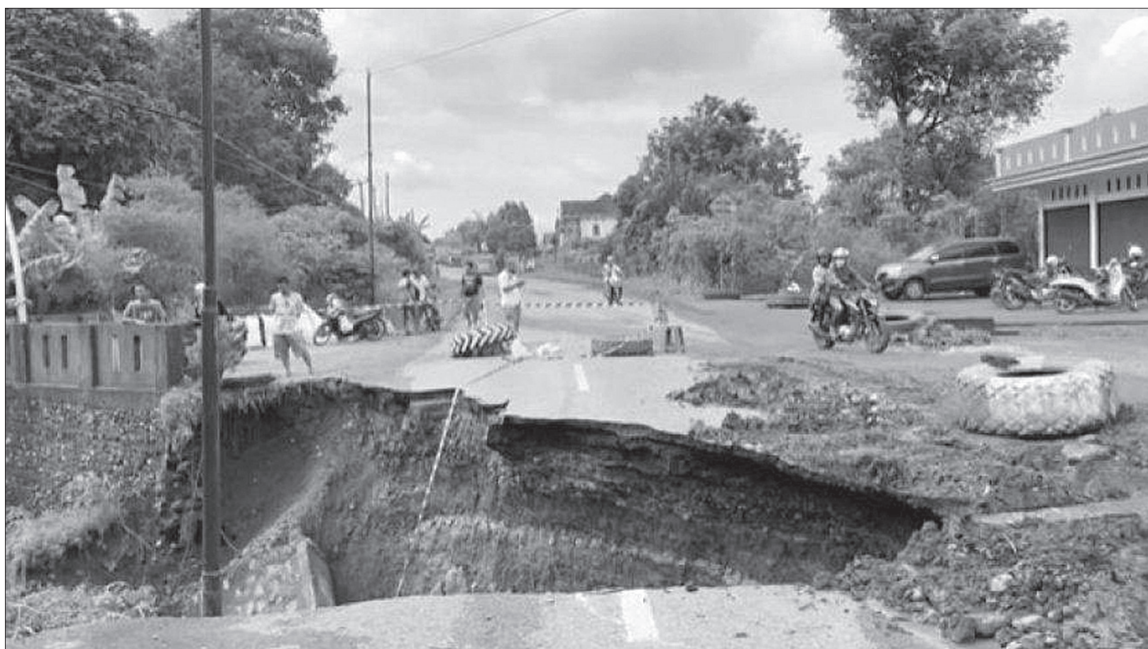
Jalintengsum yang menghubungkan Kabupaten Muara Enim-Kabupaten OKU persisnya di Desa Kaban Agung Kecamatan Lawang Kidul, Muara Enim amblas.
