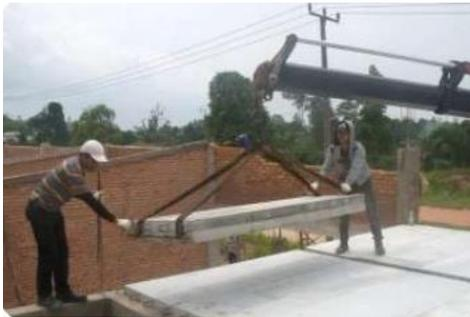
**Gambar 4.24** Pekerjaan Plat Lantai *Precast*
