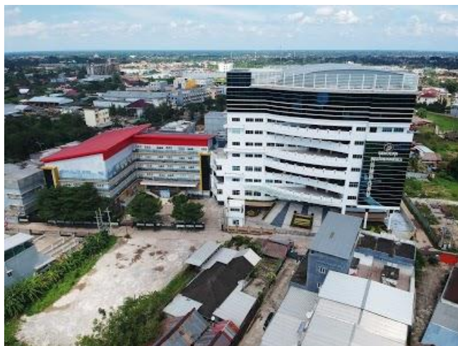
Gambar 5. Kondisi Sekitar Gedung Maitreyawira Convention Center (Sumber: Pribadi, 2022)
